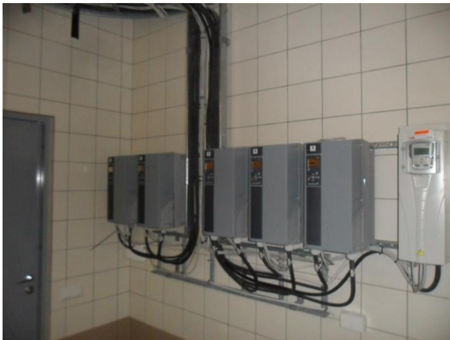
Joonis 6-11 Keskpumpla sagedusmuundurid
