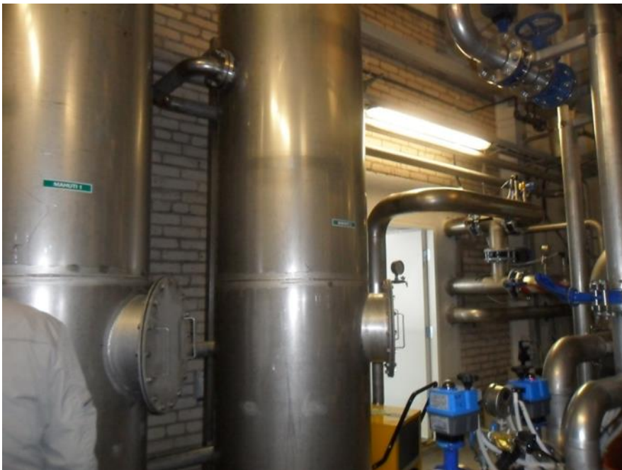
Joonis 6-15 Mikrorajooni VTJ kontaktmahutid
