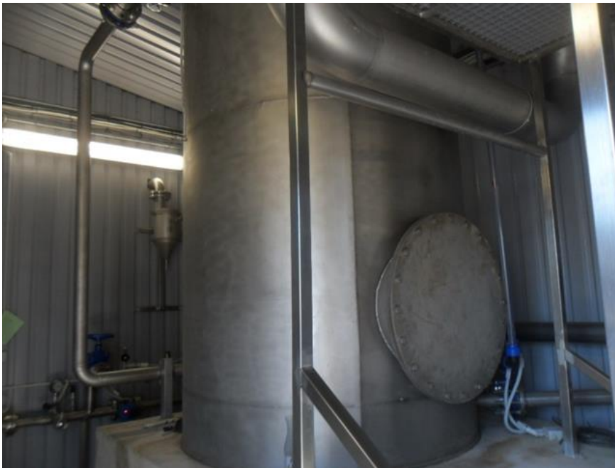
Joonis 6-4 Pk-8 rauaeraldusfilter
