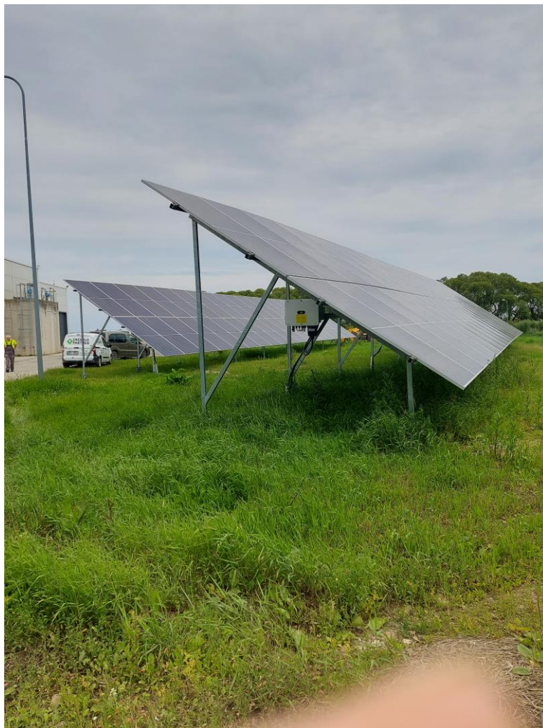
Joonis 6-24 Reoveepuhasti territooriumile paigaldatud päikesepaneelid
