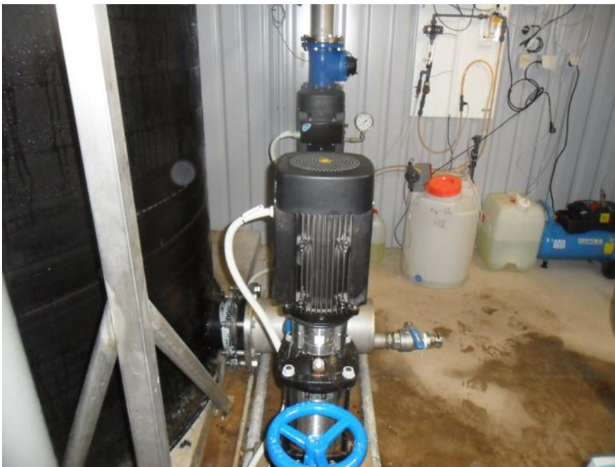
Joonis 6-6 II-astme pump, tagapool uhtepump ja seina ääres NaOCl seade
