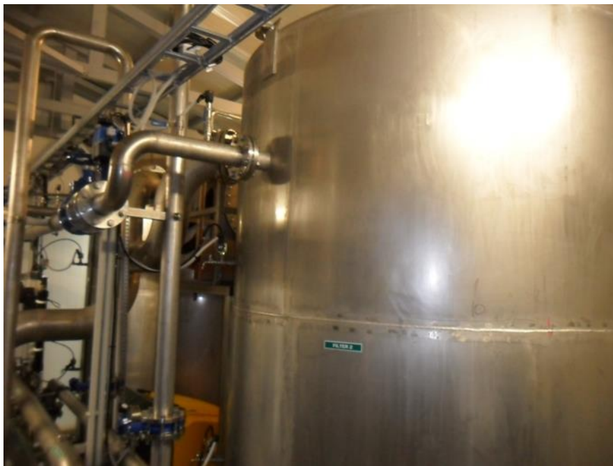
Joonis 6-16 Mikrorajooni VTJ gravitatsioonilise filtri paagid
