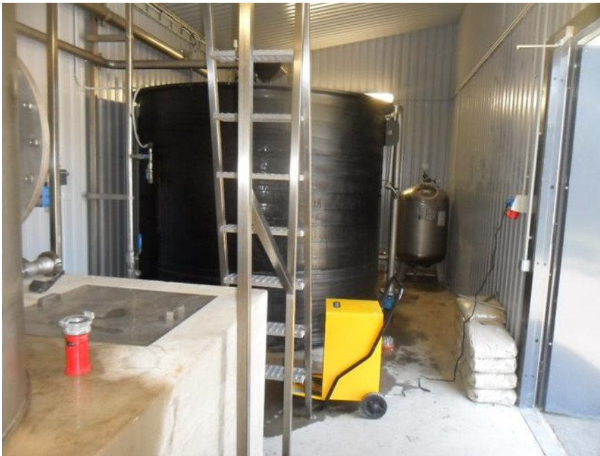
Joonis 6-5 puhtaveereservuaar, 9 m 3 (esiplaanil õhukuivati, tagapool nähtav hüdrofoor, 500 l)
