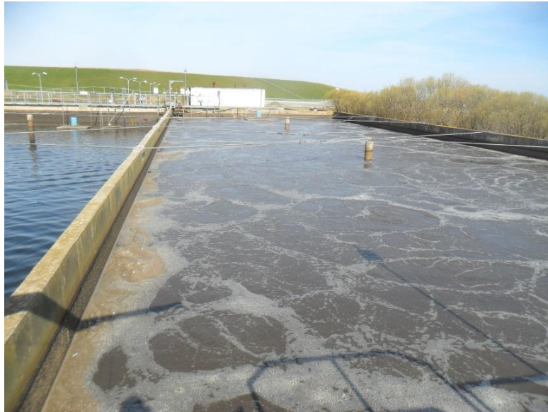
Joonis 6-23 Bioloogiline puhastus, SBR-mahuti
